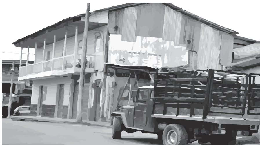
Foto 1. Proceso paulatino de renovación arquitectónica, sector centro del corregimiento de Altagracia. Fuente: Propia.
