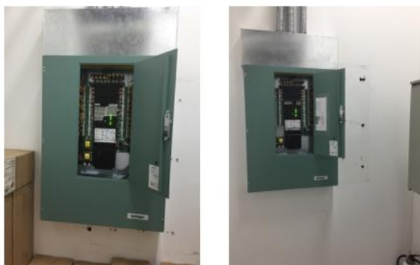
Ilustración 40. Automatización 2017: obras de automatización, control de accesos y repotenciación de tecnologías del sistema de iluminación edificio 13B (Antiguo Bloque Y Sur)
