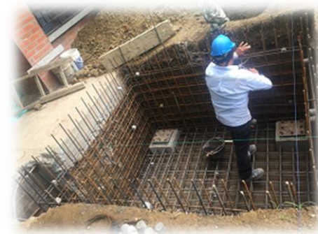
Foso de Ascensor
