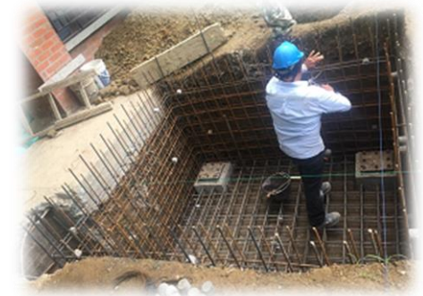
Foso de Ascensor
