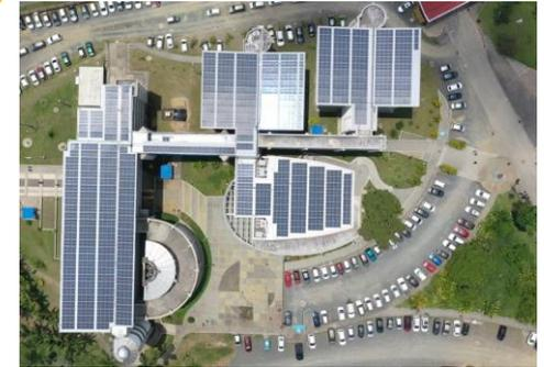
Puesta en funcionamiento del sistema solar fotovoltaico en Convenio con la Empresa de Energía de Pereira con capacidad de **603 kWp**, (cobrimiento de la demanda de la UTP en un **32%**)
