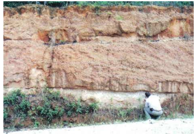
Figura 5. Corte de carretera en la vía Puerto Berrío-Remedios, donde se observan distintos estratos sedimentarios.
