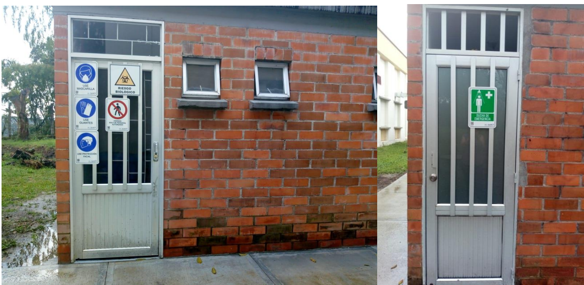
Figura 12. Depósito de residuos peligrosos con riesgo biológico y ducha de personal encargado de la ruta de riesgo biológico.
