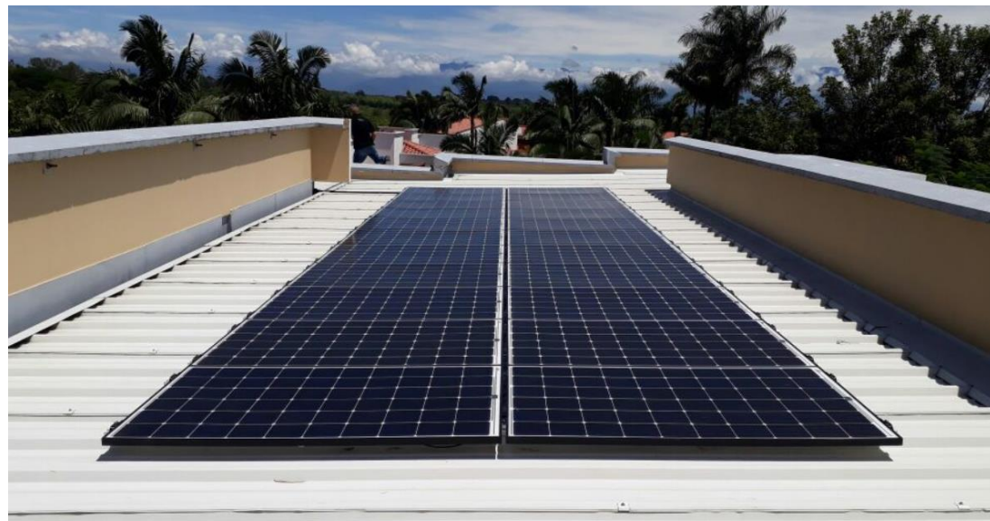
SISTEMA FV INTERCONECTADO-6.38 KW ALTOS DE QUIMBAYA-CERRITOS
