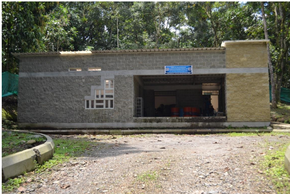
Ilustración 11. Centro de Almacenamiento Temporal - CAT
