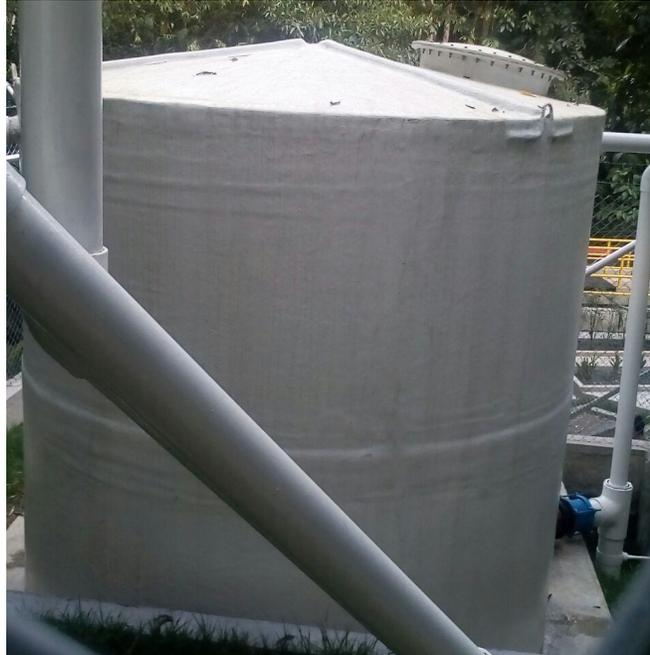
*Imagen 15. Digestor anaerobio para el tratamiento de lodos.
