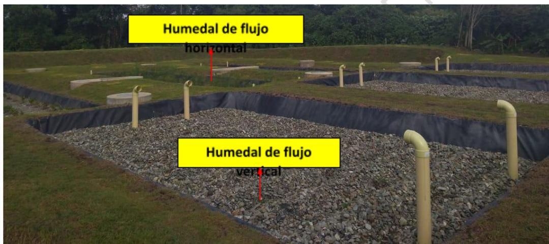
Imagen 19. Humedales artificiales, PTAR Bellas Artes.
