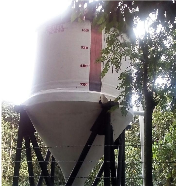
*Imagen 14. Espesador de lodos de la PTAR principal.
